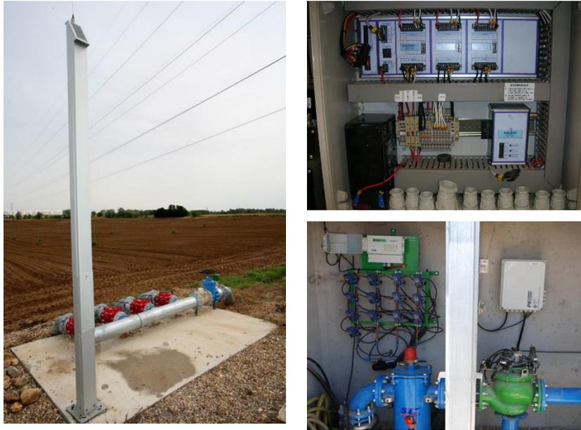
Figura 3. Sistemas de antenas de comunicación, consolas y válvulas en un Telecontrol típico. Del total de usuarios de los sistemas descritos, el 71% de las comunidades encuestadas declaró usar el sistema diariamente durante la temporada de riegos, un 8% no le da ningún uso y un 11% hace un uso escaso. Así mismo, el 68% de los encuestados usa el telecontrol para leer los contadores y un 55% factura usando las lecturas del telecontrol.
