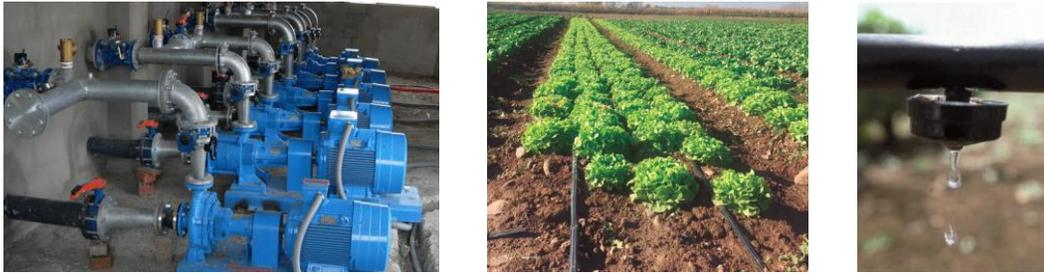
Figura 18. Riego tecnificado con equipos de bombeo, riego localizado y emisor.
