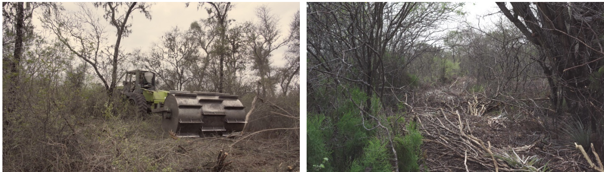
Figura 7. Corte y aplastado de arbustos con el rolo.
