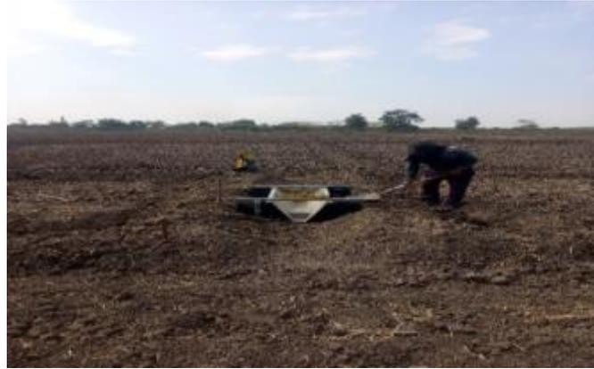
Fotografía 2. Instalación de canaleta tipo Parshall. Perú.
