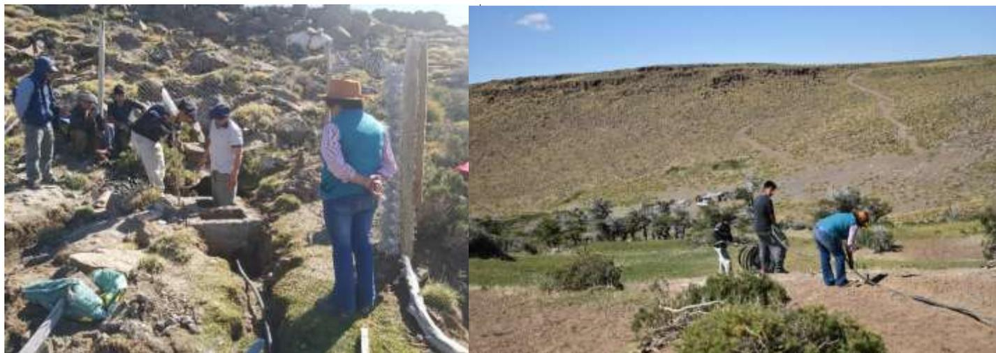
Figura 10: Vertiente construida en mampostería y cercada para garantizar un abastecimiento limpio y confiable. Figura 11: Utilización de mangueras para transportar el agua de la vertiente a la casa de la productora. Campo demostrador de Zapala, Neuquén.
