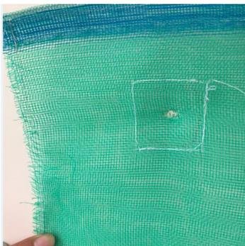
Figura 29. Refuerzo en la malla mosquitera para abertura por donde pasará el tubo PVC.
